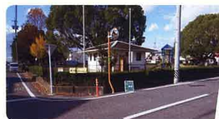
カーブミラーの設置
