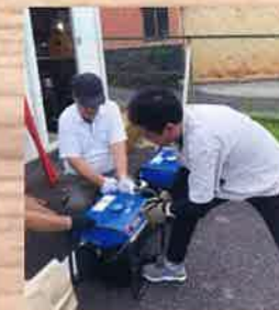
発電機の始動を定期的に点検
