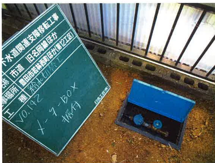
メーターBOX 取替え工事
