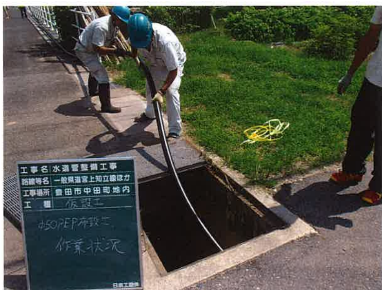
仮設本管工事
