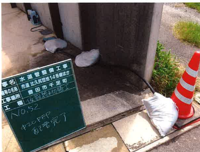
仮設給水工事
