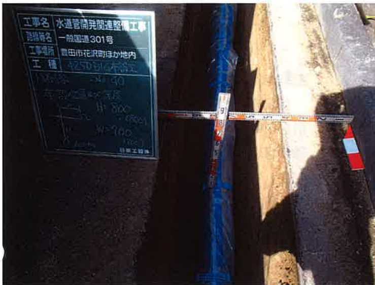
水道管布設工事
