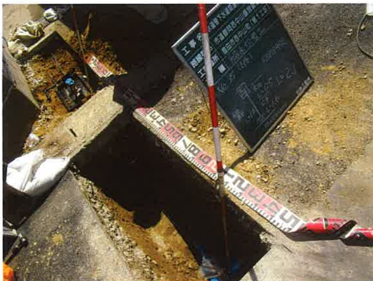
給水管取り替え工事
