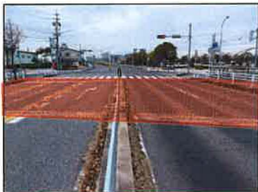
橋の上：舗装 伸縮装置
