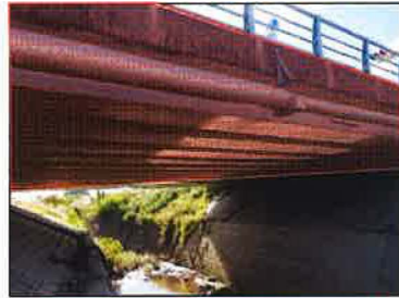
橋の下：足場設置
